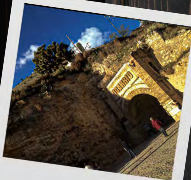
Túnel de Ogarrío, Real de Catorce
