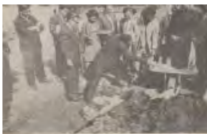
Primera piedra puesta por Arqueles Vela para la construcción del edificio de Física y Química, recién estrenado en 1973, para la apertura de cursos del Turno Matutino. Archivo ENSM.
